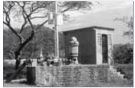
Foto 36. Bomba de impulsión de agua sobre el NCI.
